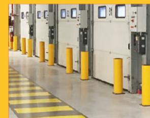
Protection des angles et glissières de portes sectionnelles dans un centre logistique neuf en région parisienne.
