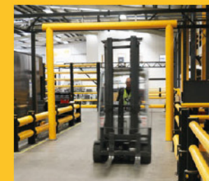
Restricteur de Hauteur protégeant l'alimentation pneumatique et électrique en hauteur dans un site industriel.
