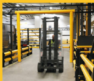
Restricteur de Hauteur protégeant l'alimentation pneumatique et électrique en hauteur dans un site industriel.
