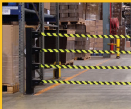
Zeer zichtbare tape als begeleiding uit gevaarlijke zones.
